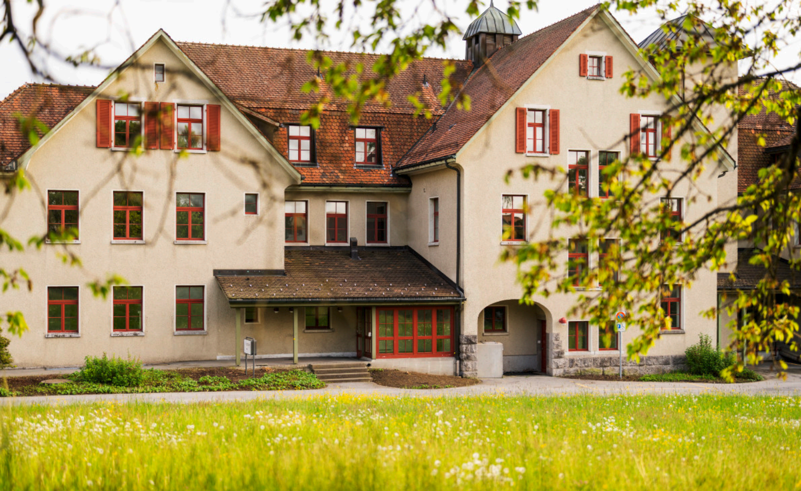
Haus 3 vor der Renovation
