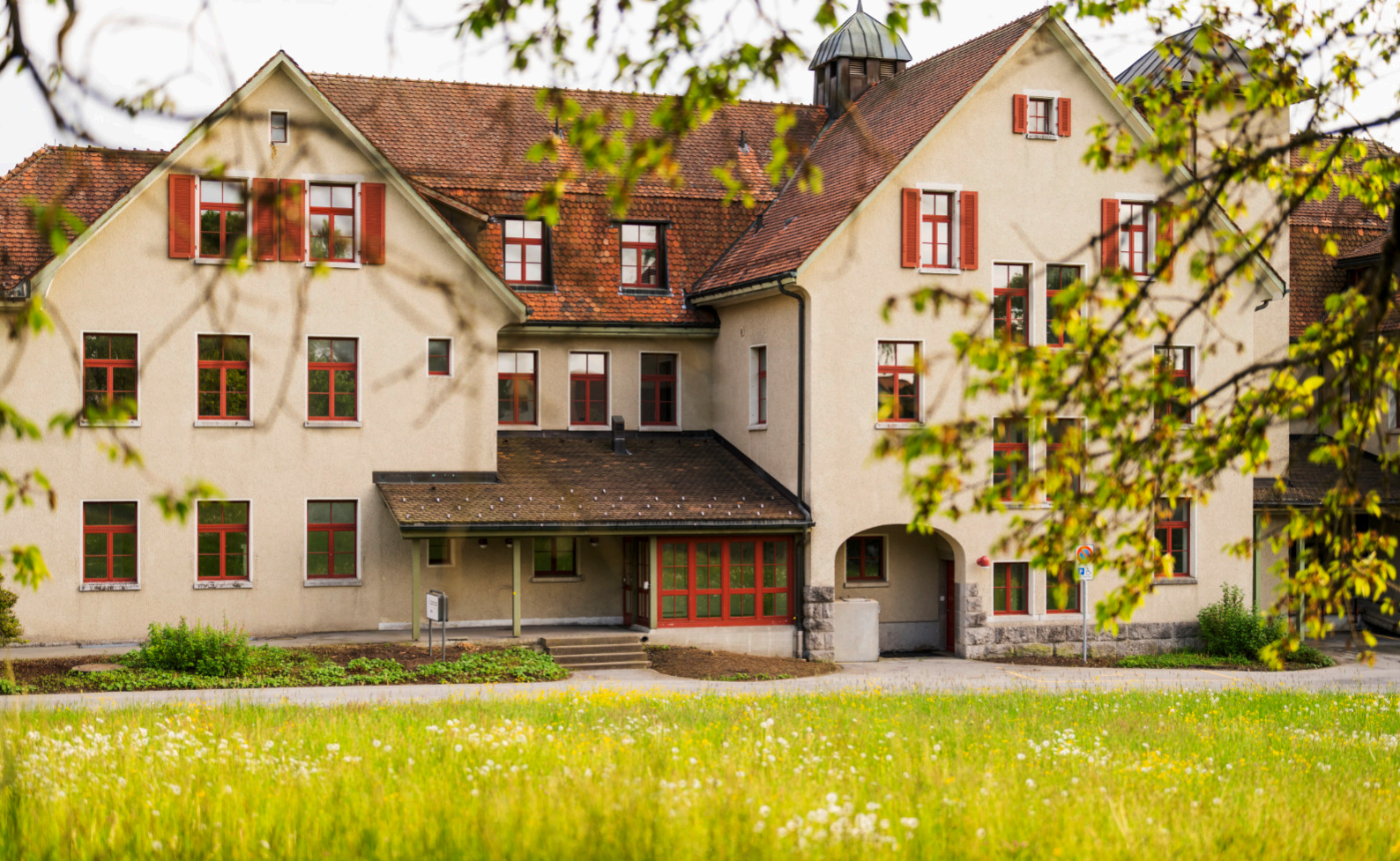
Haus 3 vor der Renovation
